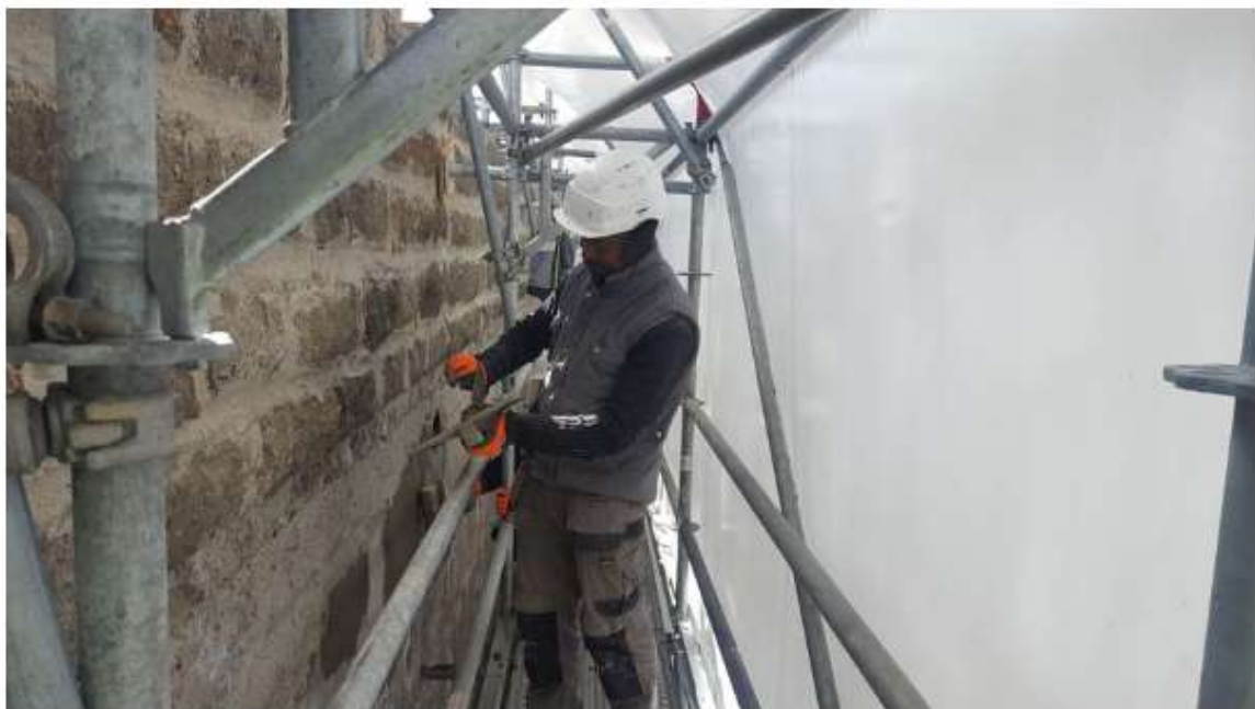
Les ouvriers colmatent les fuites dans l'édifice vieux de plus de 100 ans © Radio France - Sébastien Berriot
