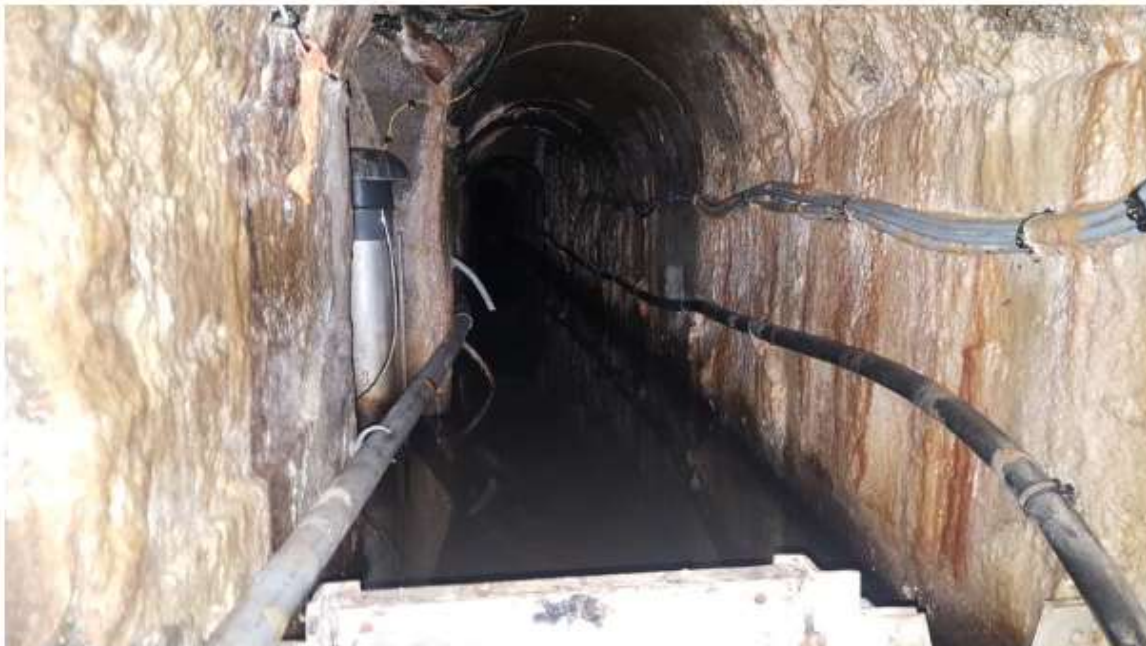
C'est dans les entrailles du barrage que les fuites sont surveillées © Radio France - Sébastien Berriot
