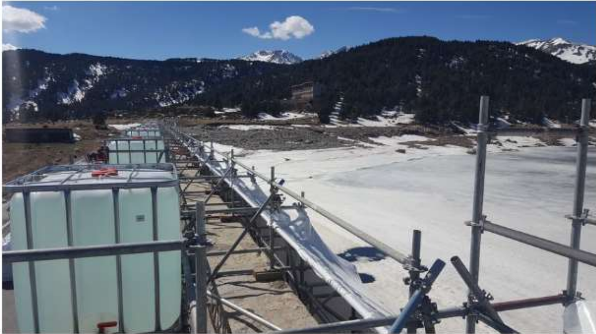
Le chantier du barrage © Radio France - Sébastien Berriot
