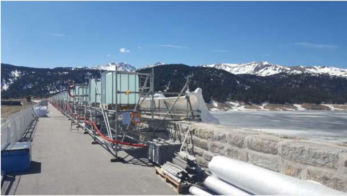
L'échafaudage suspendu qui tient grâce au contre-poids d'énormes bidons d'eau © Radio France - Sébastien Berriot
