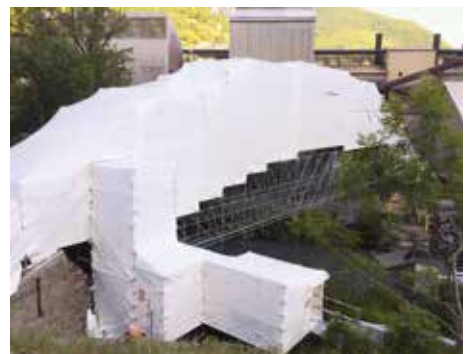
DÉSAMIANTAGE DE LA CONDUITE FORCÉE DE BEYRÈDE (65)
