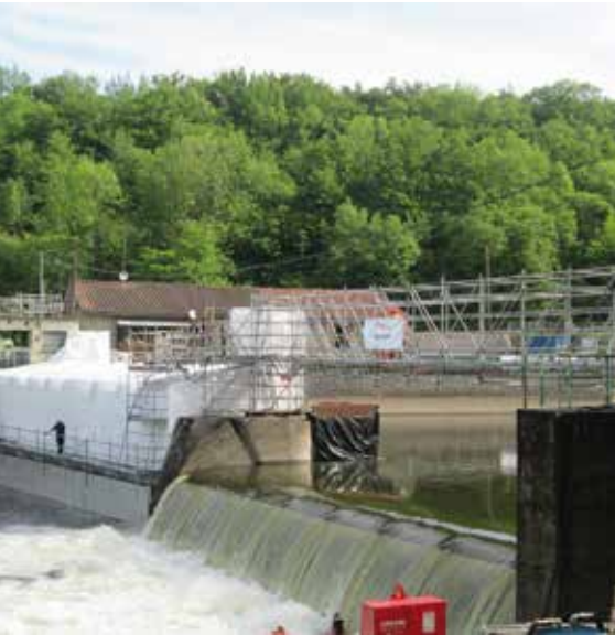
DÉSAMIANTAGE DU BARRAGE EDF LES SALVAGES (81)
