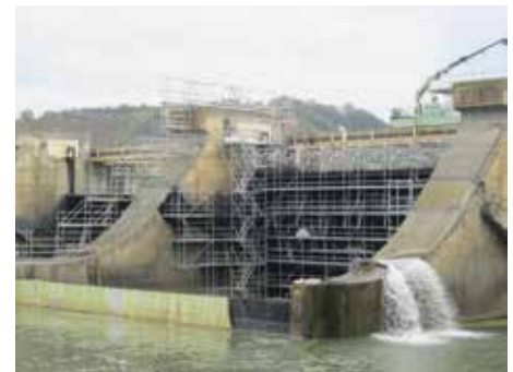
DÉSAMIANTAGE DU BARRAGE EDF DE MALAUSE (82)
